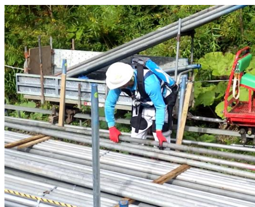
鉄筋を持ち上げ台車に載せる作業で、マッスルスーツ®を使用。前傾姿勢での重量物の持ち上げ作業は長時間続くという。この作業員の身体の負担を軽減する。
